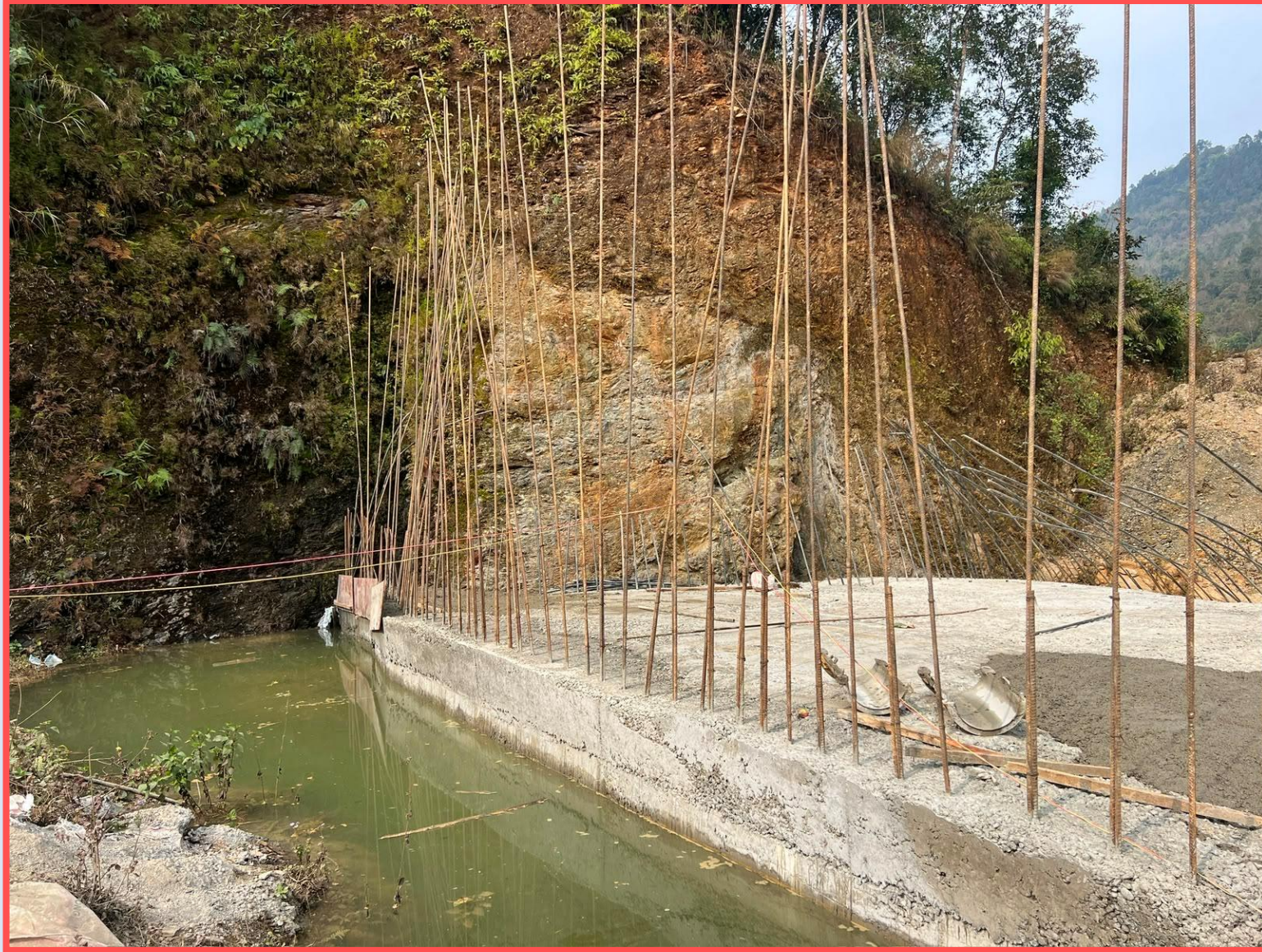
घुमाउने ताल बाँध निर्माण
